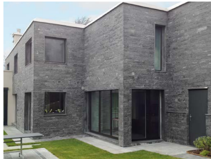
Fassadensanierung mit stoneface: vom 0815-Objekt aus Backstein zum wunderschönen Rockresort in Tessiner Onsernone Gneis, mit bruchrohen Riemchen mit gestossenen Fugen.
