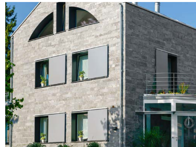
Fassadensanierung mit stoneface: vom einfachen verputzten Objekt zum wunderschönen Rockresort in Valser Quarzit mit bruchrohen Riemchen mit gestossenen Fugen.
