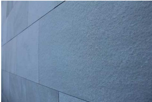
*Rooterberger Sandstein, Oberfläche geflammt (1'700m<sup>2</sup>)*
