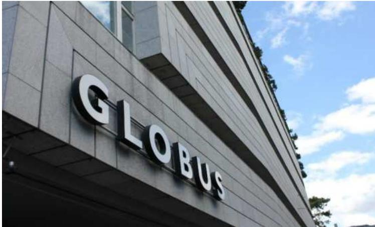
*Fassade in Iragna Gneis T1, Oberfläche geflammt (2'200m<sup>2</sup>)*
